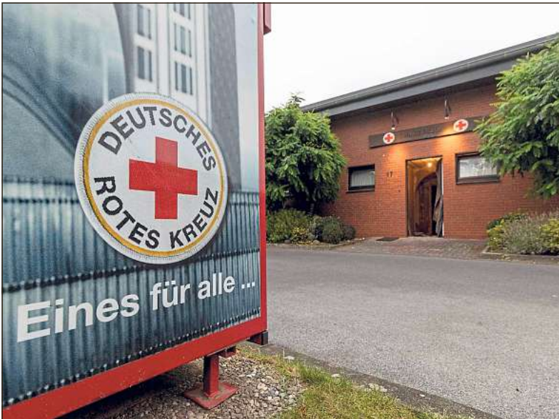
Generalüberholt wird derzeit das DRK-Heim an der Winkelstraße. Viele Arbeiten erledigen die DRKler dabei in Eigenleistung.
