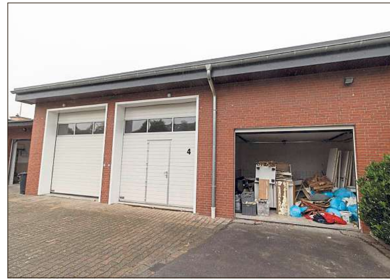
Beim Entrümpeln wird Platz für Neues geschaffen. Die Garagentore wurden schon verbreitert und automatisiert.
